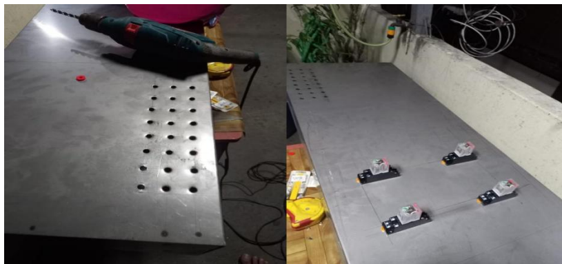
Figura 3. Montaje de elementos eléctricos
