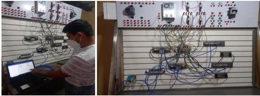
Figura 5. Verificación previa para ejecución de práctica
