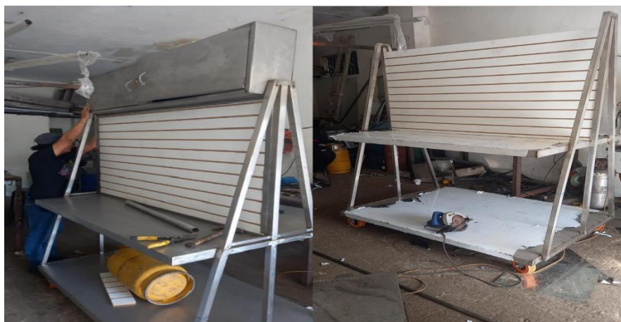
Figura 1. Montaje de base y panel didáctico
