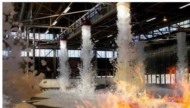
Figura 1. Sistema de espumas contra incendios
