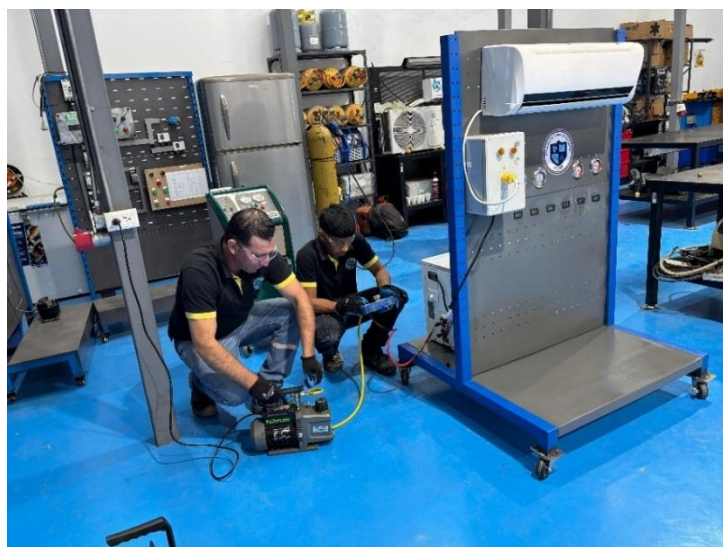
Figura 4. Intervención técnica para la verificación y vacío del sistema
