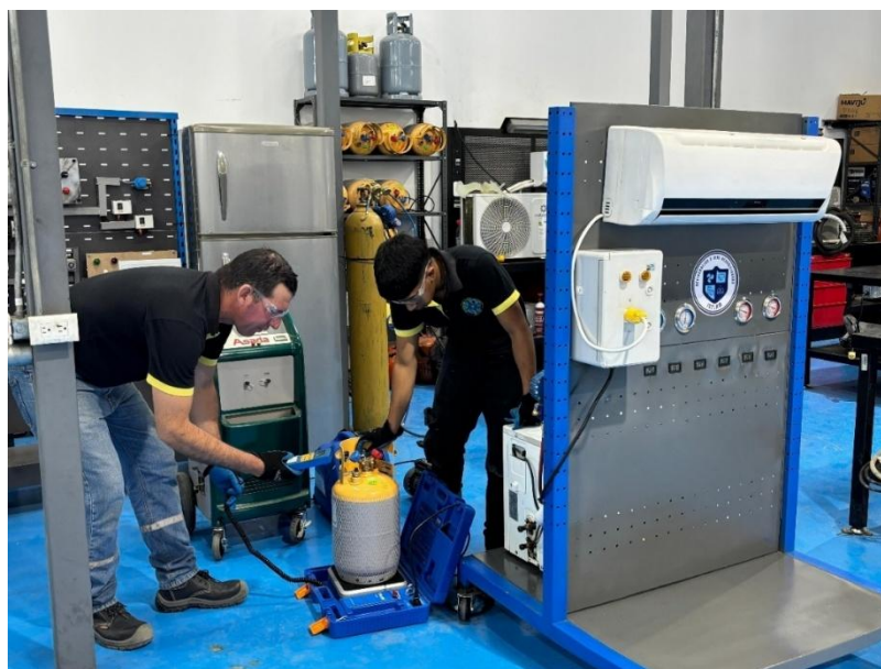
Figura 6. Carga de refrigerante durante el mantenimiento del aire acondicionado tipo Split
