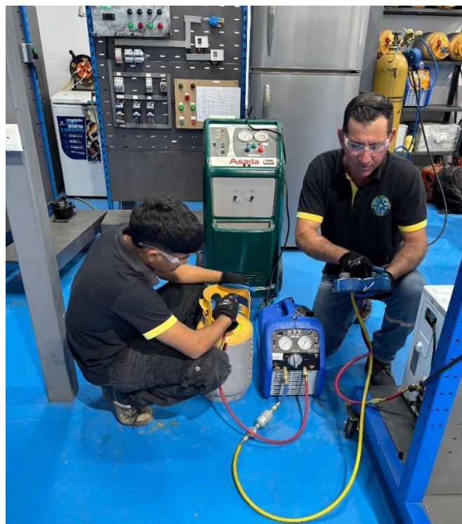
Figura 3. Recuperación del refrigerante R22 del equipo original.
